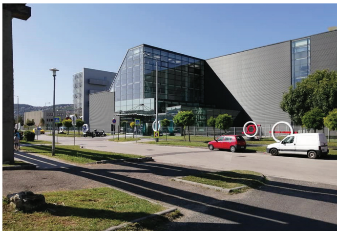
Az MTVA épülete
